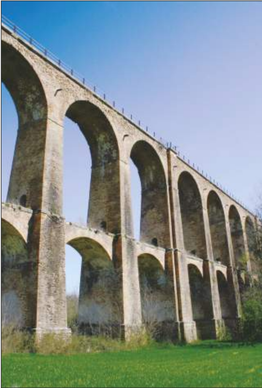
Viadotto ferroviario di San Bartolomeo
