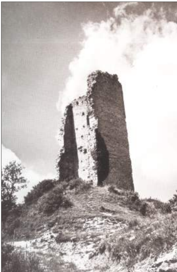
Torre Bregna poco prima del crollo, avvenuto nel 1979
